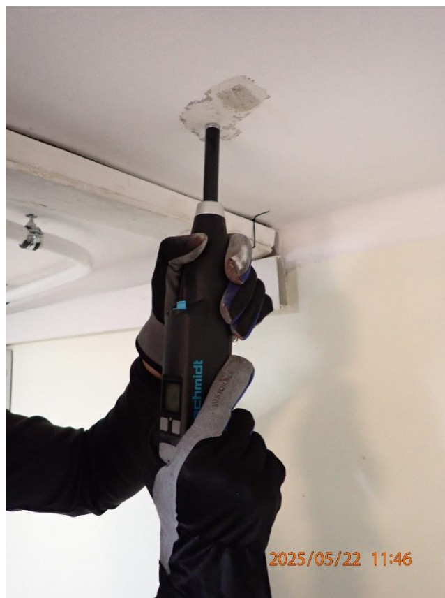
Nuotrauka Nr. 4. Perdangos plokštės betono stiprio nustatymas
